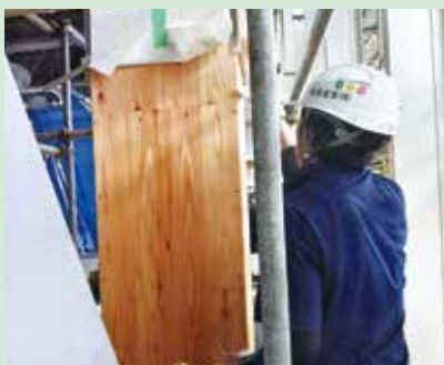
現場カバー工事
