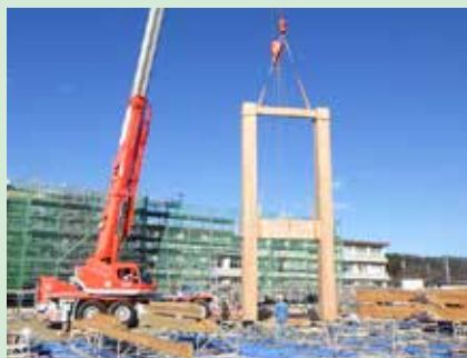
地組フレームの建て起こし
