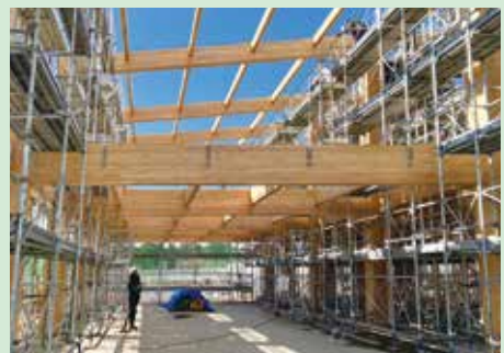
建て込み小梁取付
