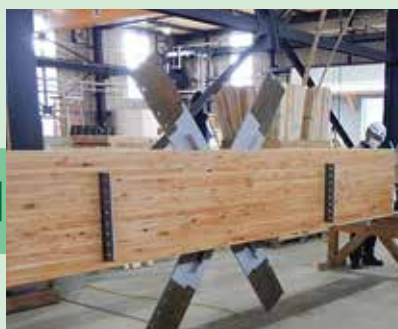
鉄骨組み込み
